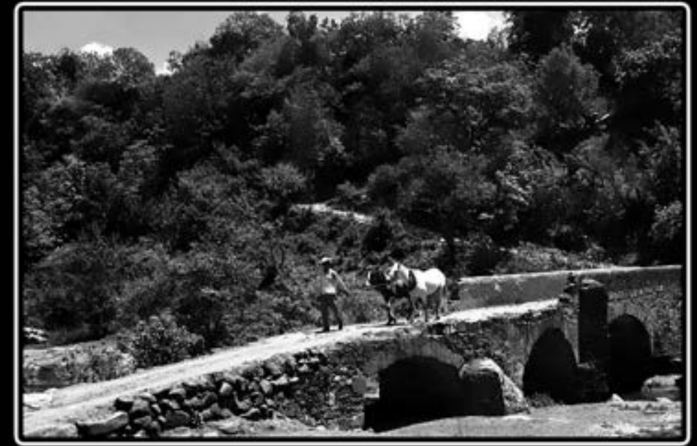
Puente del Río de San Pedro 1971
