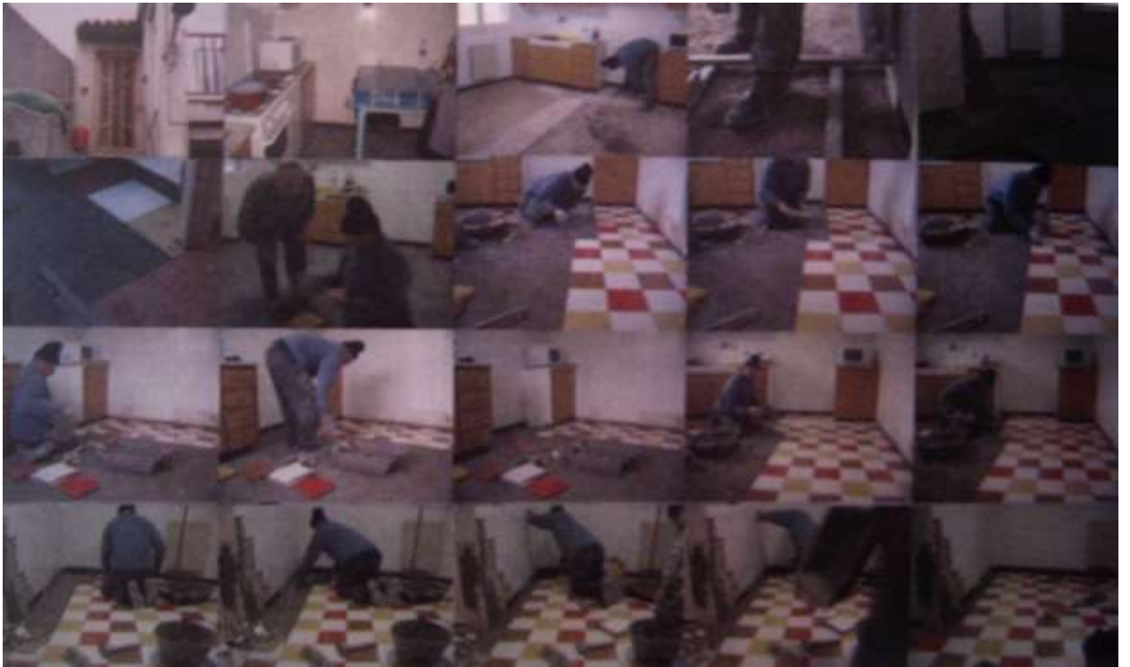
Intervención en suelo de la cocina de Joseph Vilaseca, en el casco antiguo de Calaf
