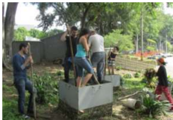
Imagen 2: Construcción de la Paca Biodigestora en el proceso de compactación.
