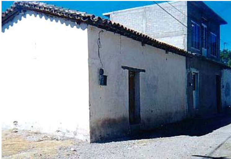
A la izq. vivienda de adobe con techo de teja en dos aguas; a la der. vivienda de varilla y concreto en dos niveles
