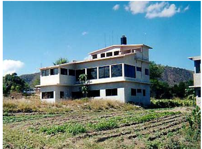
Vivienda de ladrillo y concreto en tres niveles
