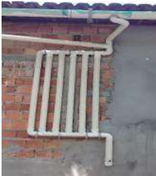
Figura 10 – Estrutura de descarte DESVIUFPE do Sítio Experimental de Cuiarana, Salinópolis-PA.
