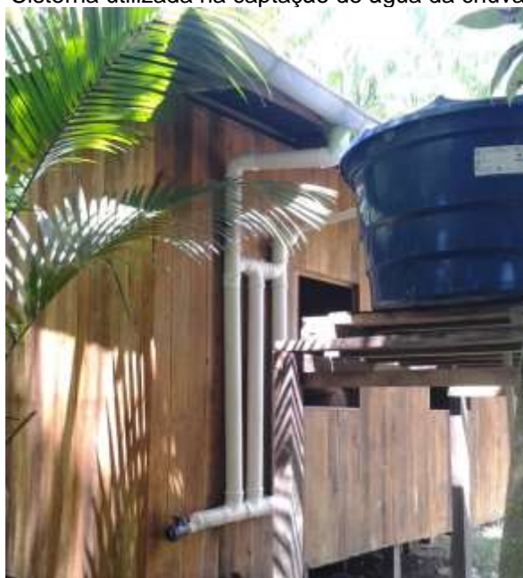
Figura 6 – Cisterna utilizada na captação de água da chuva do projeto.
