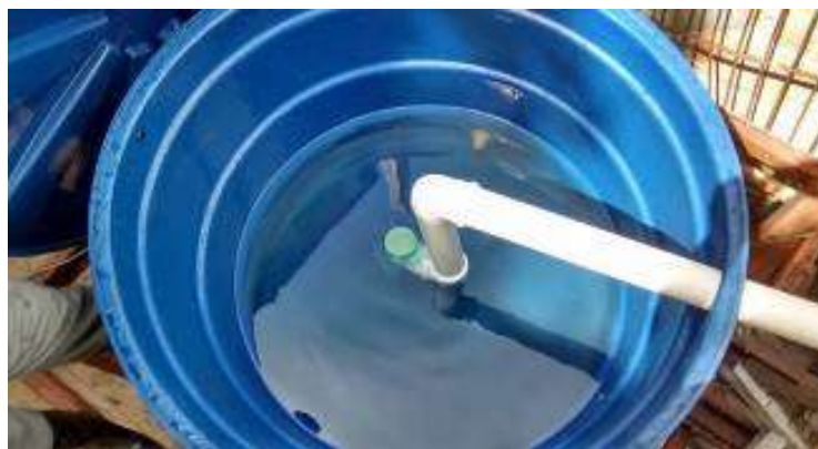
Figura 11 – Reservatório com redutor de turbulência.
